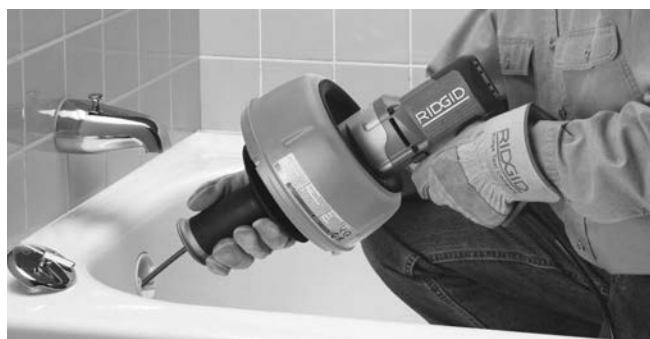
Obrázok 9 – Zatláčanie kábla do potrubia odtoku
