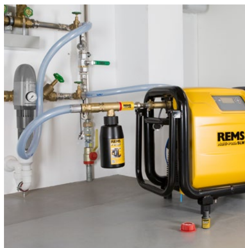
Dezinfekcia rozvodov pitnej vody
