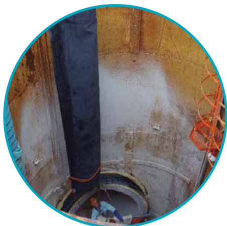
Vkládání složeného polštářového těsnícího vaku
