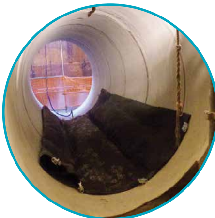
Umísťování – polštářový vak by měl být položen horizontálně
