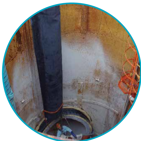
Vkládání složeného polštářového těsnícího vaku
