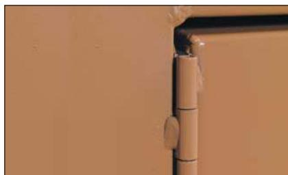
Panty pro velké zatížení jsou ukotveny a svařeny tak, aby vydržely jakékoli páčení.
