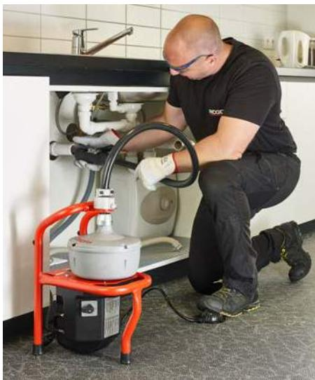
**V umyvadle:** Stlačte páku a spirála se bude posouvat do odpadu. Jedinečná kombinace vodící hadice a autoposuvu AUTOFEED® vám umožní vypořádat se s problémem.
