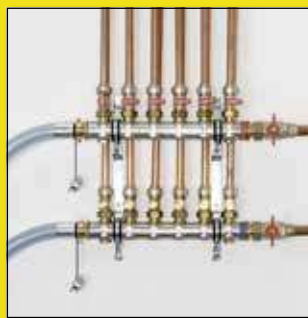
Preplachovanie radiátorov a plošných vykurovacích systémov (S/SL/SLW)
