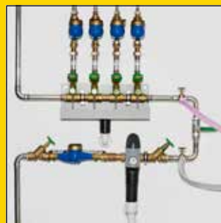
Preplachovanie rozvodov pitnej vody (S/SL/SLW)
