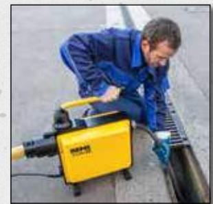
Rýchlootáčavé zariadenie s delenými špirálami pre pracovnú dĺžku do 70 m. Účinné omieňanie reťazami a frézovanie až 740 min<sup>-1</sup>.
