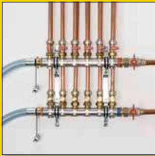
Preplachovanie radiátorov a plošných vykurovacích systémov (S/SL/SLW)
