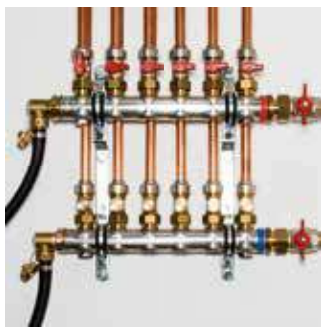
Preplachovanie radiátorov a plošných vykurovacích systémov
