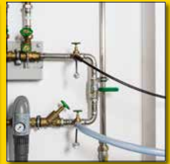
Nyomáspróba víz segítségével (SLW)
