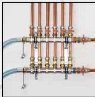
Proplachování radiátorů a plošných topných systémů (S/SL/SLW)
