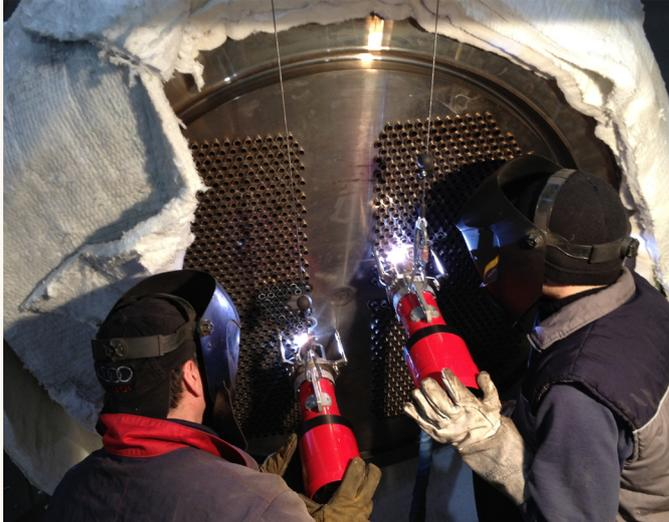
Der SATP-80X deckt nahezu alle gängigen Konfigurationen des Rohr-in-Boden-Schweißens ab, und zwar sowohl für Edelstahl, sogar Titan, als auch für Normalstahl. Bei Rohr-in-Boden-Anwendungen spielt die Vorbereitung eine sehr wichtige Rolle, um ein reproduzierbares und qualitativ hochwertiges Schweißergebnis zu ermöglichen. Folgende Schritte sind bei jedem Projekt festzulegen und sie sind für den Erfolg Ihrer Prozesse von entscheidender Bedeutung:
