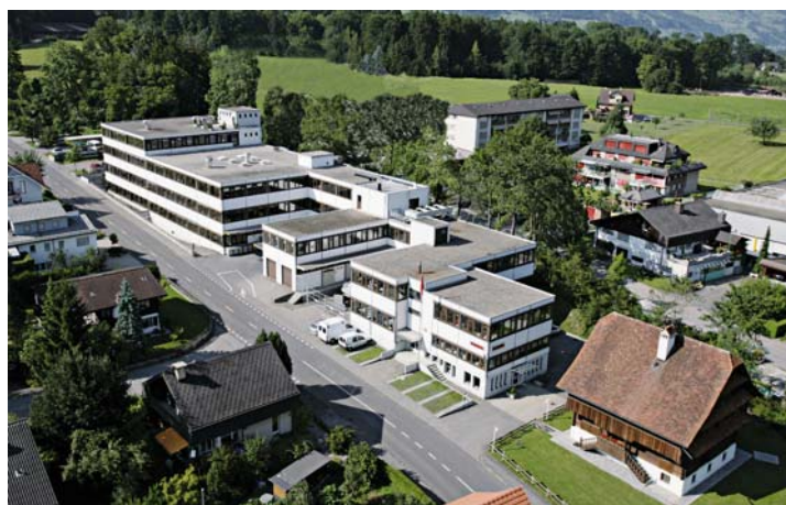
Leister Technologies AG, výrobní budovy, Kägiswil, Švýcarsko
