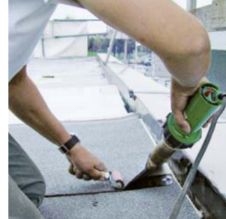
Svařování bitumenových pásů pomocí výkonného přístroje ELECTRON.
