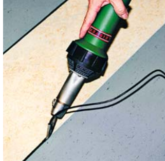
Svařování linolea s přístrojem TRIAC S vybaveným rychlosvařovací tryskou.
