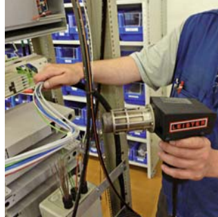
Ohřev svazků optických vláken pro snazší zpracování.
