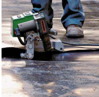
TWINNY T s kombinovaným klínem při svařování izolačního pásu HD-PE.
