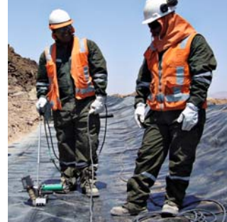
TWINNY S s kombinovaným klínem při svařování v jihoamerickém dole.
