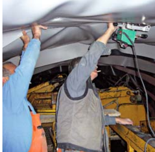
Svařování s přístrojem COMET v tunelu...
