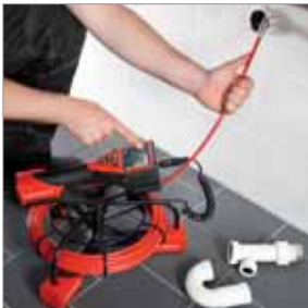
Inšpekcia vodovodných odpadov
