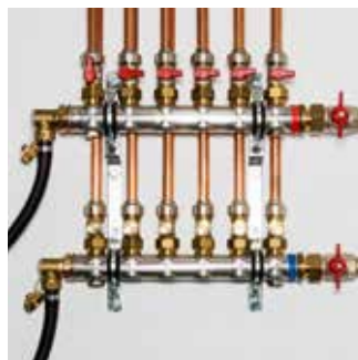
Preplachovanie radiátorov a plošných vykurovacích systémov
