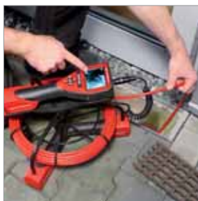
Inšpekcia dažďových potrubí
