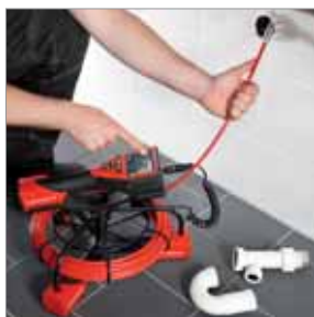
Inšpekcia vodovodných odpadov
