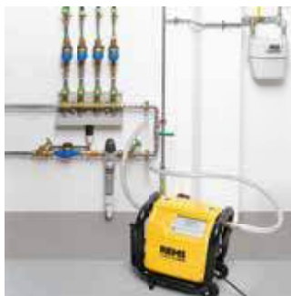
Proplachování rozvodů pitné vody
