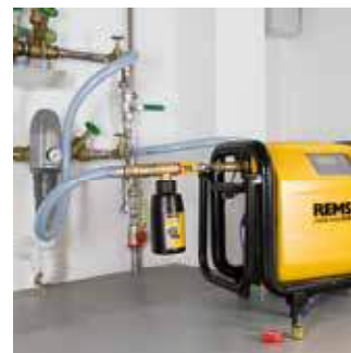
Dezinfekce rozvodů pitné vody
