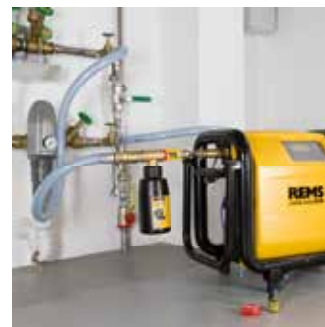
Dezinfekcia rozvodov pitnej vody
