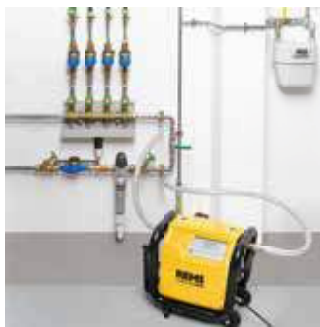
Preplachovanie rozvodov pitnej vody
