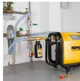
Dezinfekcia rozvodov pitnej vody
